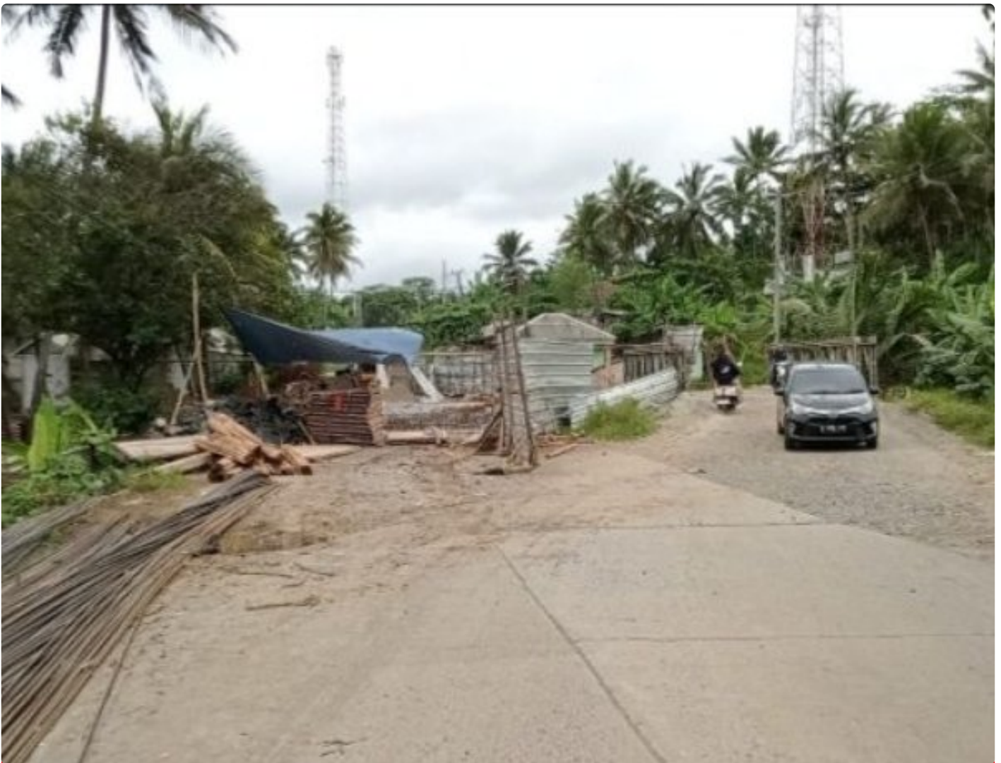
Sempat mangkrak di tahun 2023, jembatan dikerjakan kembali tahun 2024
